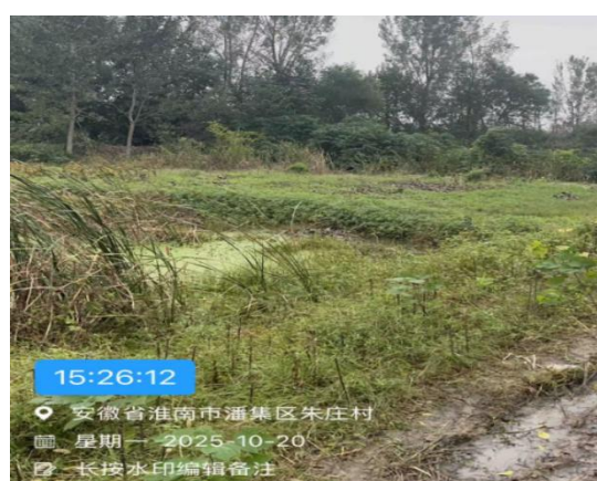
VII西补1孔井场施工前照片
